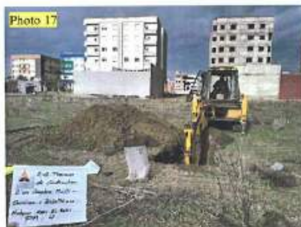
Photos 13 et 14 Montrant Les travaux de la réalisation du sondage mécanique Pm 4 .
