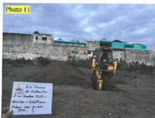
Photos 11 et 12 Montrant Les travaux de la réalisation du sondage mécanique Pm 1 .
