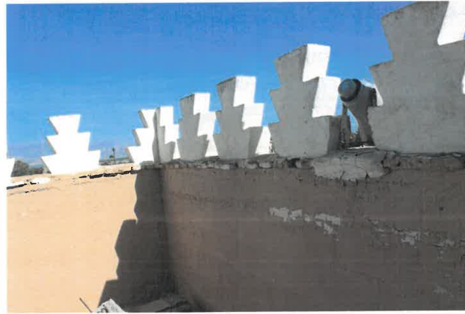
PH 93 et 94: Vieillessement des hautes parleurs extérieures
