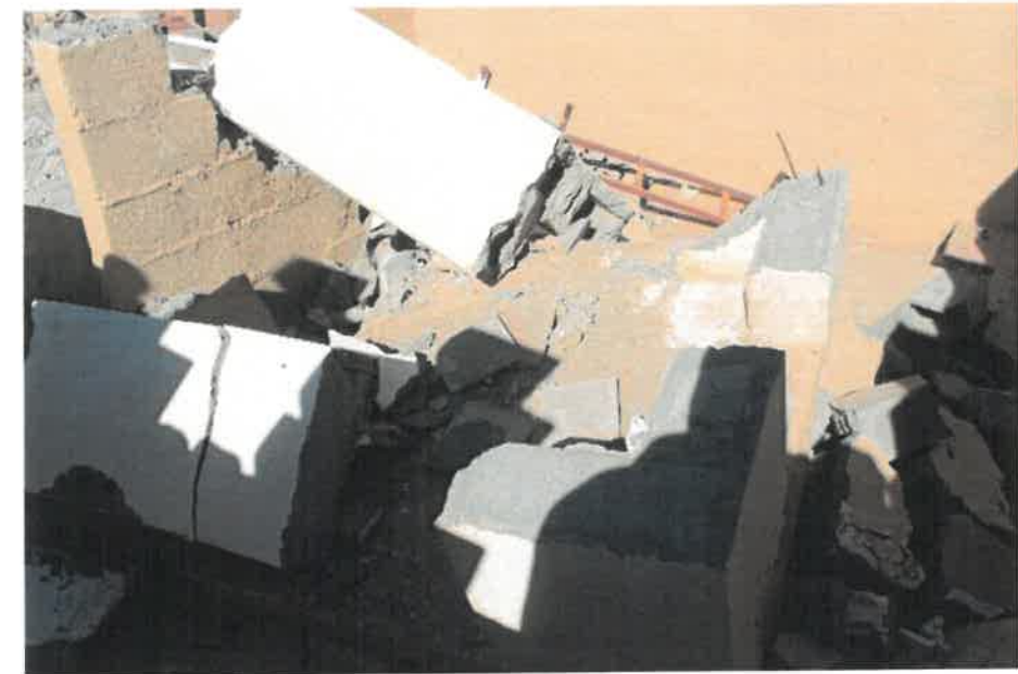
PH 75 et 76: Effondrement d'Azri et de la partie haute du minaret avec cherrafats (Eléments en béton et agglos de ciment)
