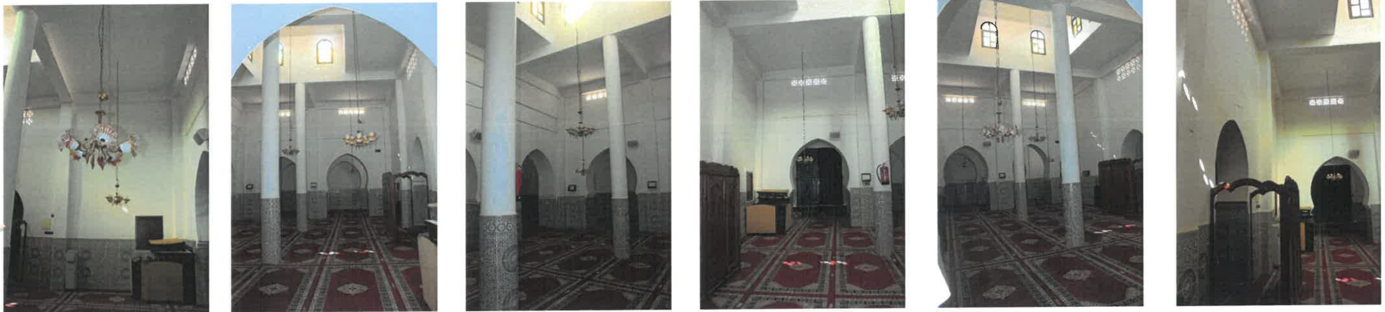
PH 45,46,47,48,49 et 50 : Couverture du Sahn par une structure en béton armé( poteaux, poutres et dalle)
