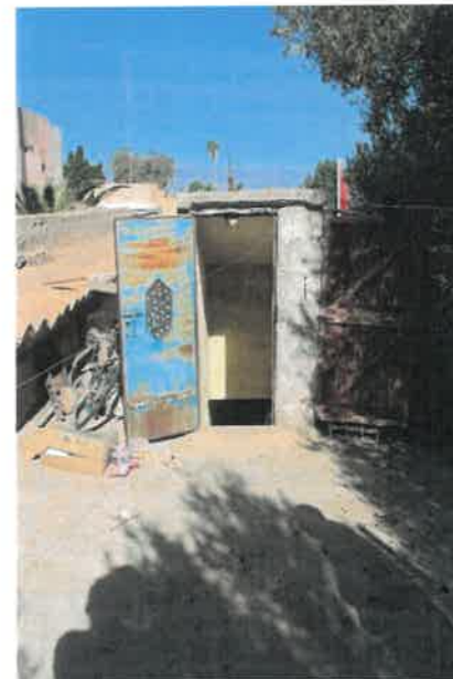
PH 84,85 et 86: Vieillessement et dégradation de la menuiserie bois et ferronnerie
