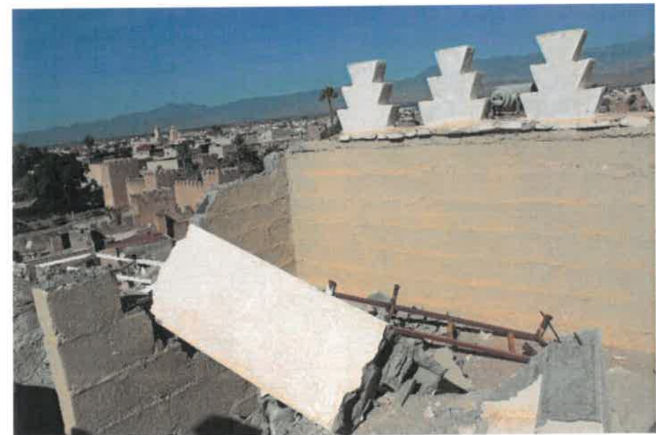
PH 75 et 76: Effondrement d'Azri et de la partie haute du minaret avec cherrafats (Eléments en béton et agglos de ciment)
