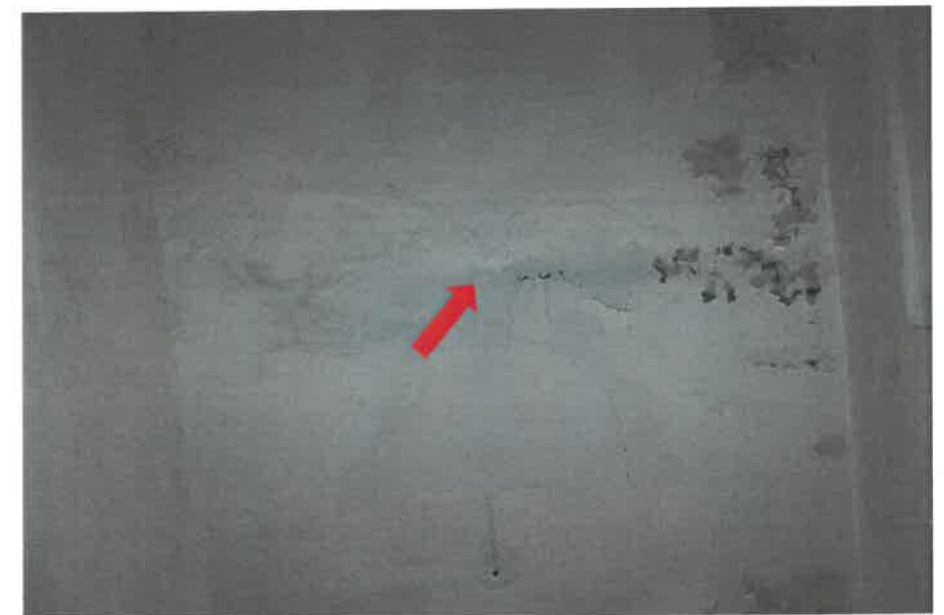
PH 22 : Fissure horizontale sur dalle
