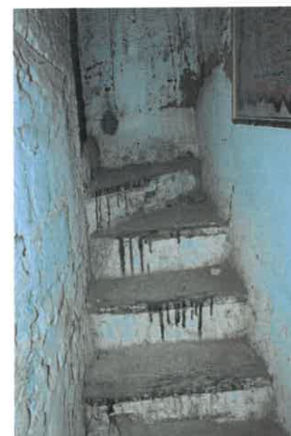
PH 64.65 et 66: Dégradation légère au escaliers du minaret
