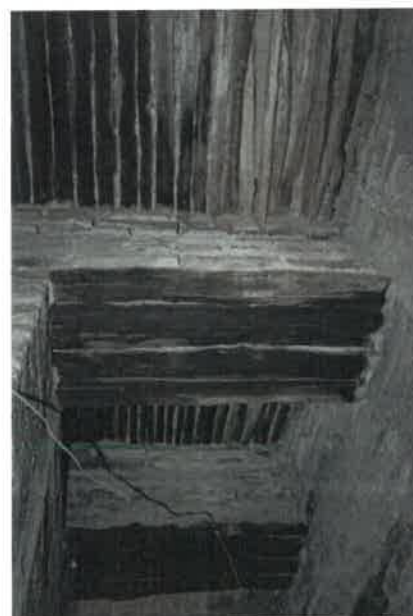
PH 61.62 et 63: Vieillesse du voligeage au niveau plancher en rondins du bois
