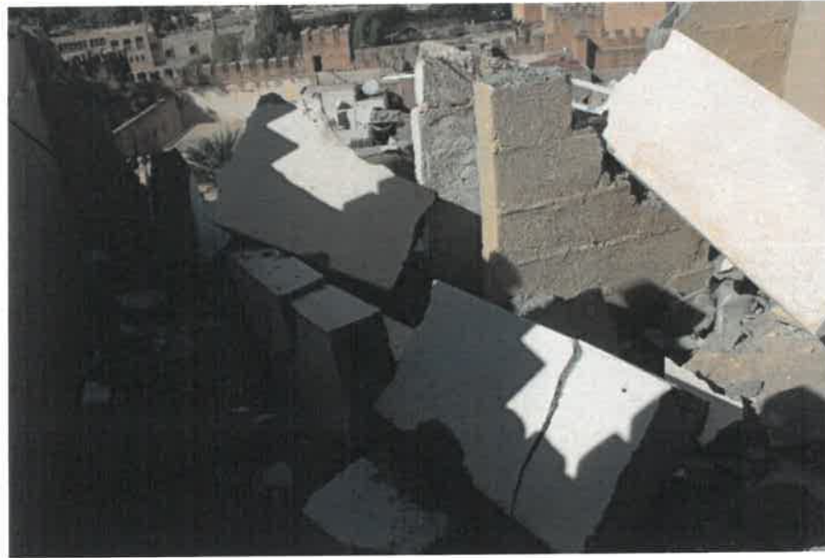
PH 75 et 76: Effondrement d'Azri et de la partie haute du minaret avec cherrafats (Eléments en béton et agglos de ciment)
