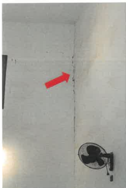
PH 19,20 et 21 : Fissure horizontale et verticale sur mur
