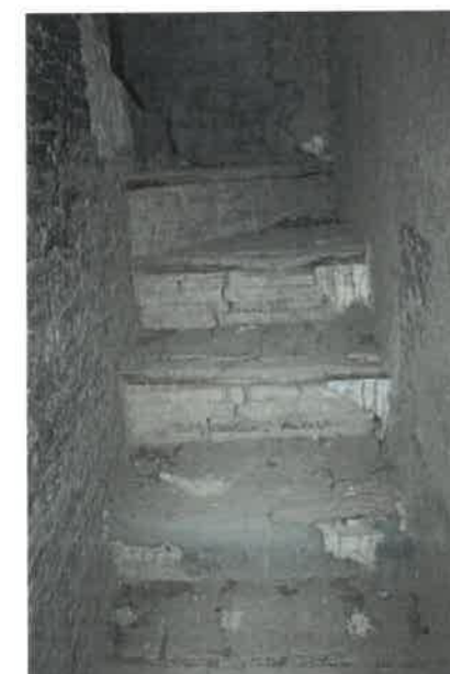
PH 64.65 et 66: Dégradation légère au escaliers du minaret
