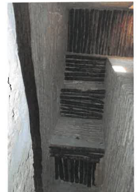
PH 58.59 et 60: Dégradation légère au niveau plancher en rondins du bois
