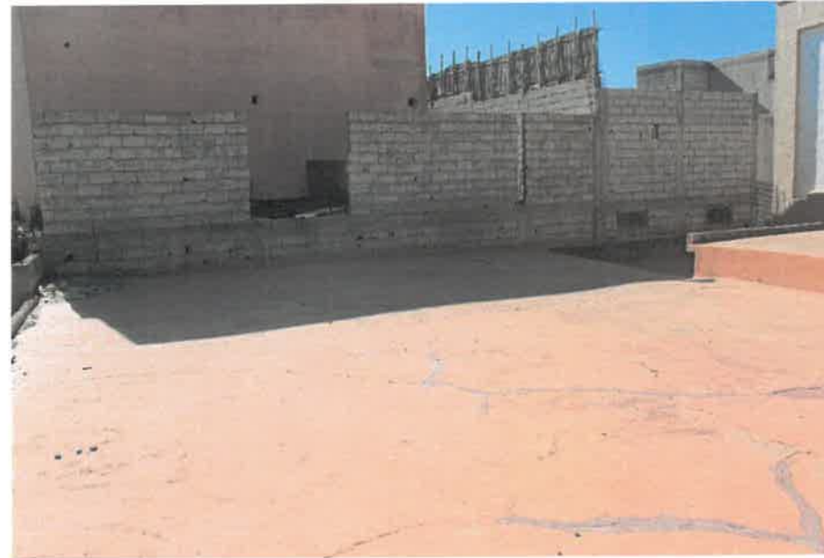
PH 38,39,40 ET 41 : Dégradation de la chape de ciment sur terrasse
