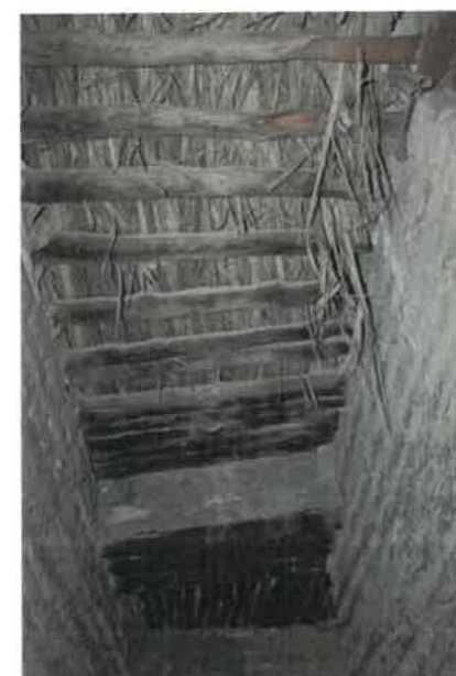
PH 61.62 et 63: Vieillesse du voligeage au niveau plancher en rondins du bois
