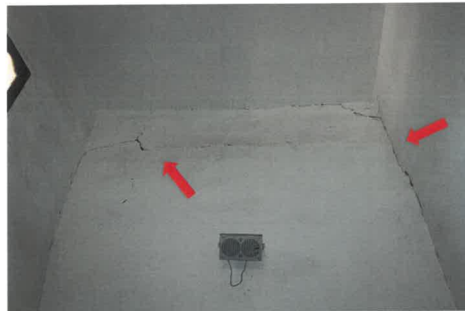
PH 19,20 et 21 : Fissure horizontale et verticale sur mur
