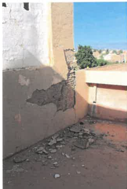
PH 55.56 et 57: Dégradation de la maçonnerie en élévation
