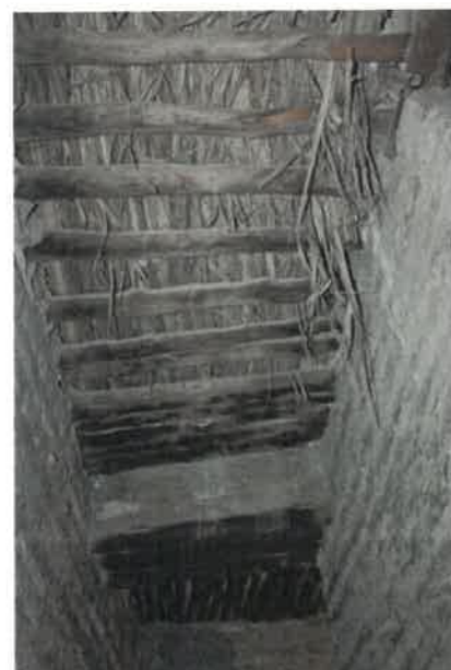
PH 61.62 et 63: Vieillesse du voligeage au niveau plancher en rondins du bois
