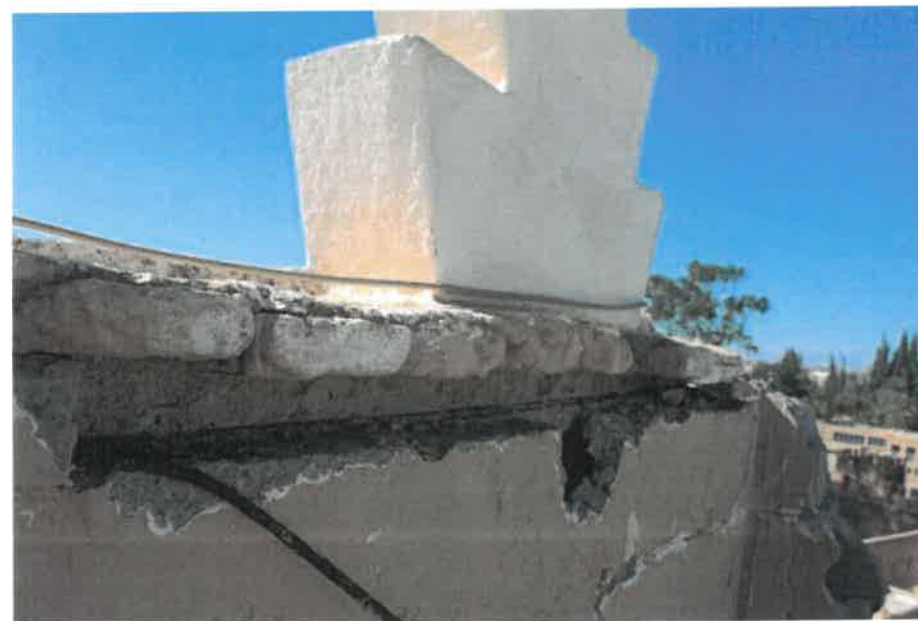
PH 77 et 78: Effondrement d'Azri et de la partie haute du minaret avec cherrafats (Eléments en béton et agglos de ciment)
