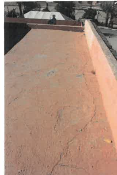
PH 42,43 ET 44 : Dégradation de la chape de ciment sur terrasse
