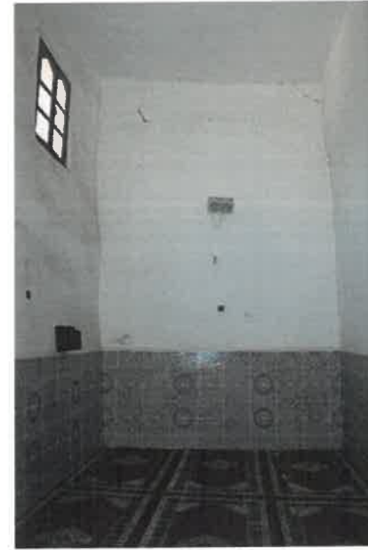
PH 31,32 et 33 : présence de revêtement en grés cérame sur mur S,P,H
