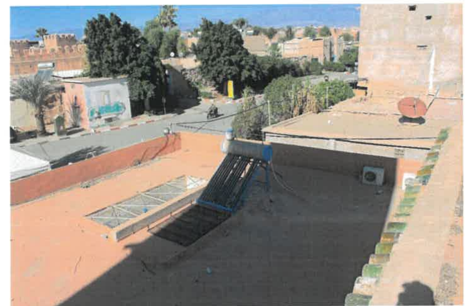
PH 95: Vieillessement de chauffe-eau solaire
