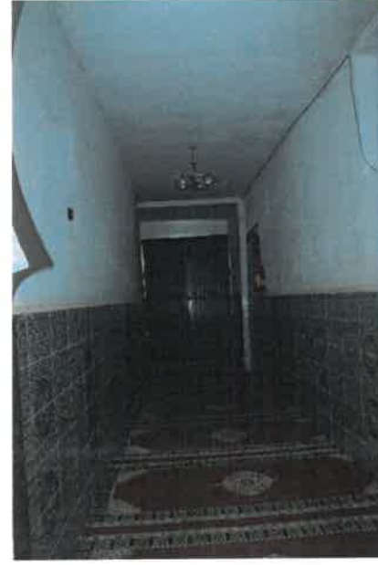
PH 34,35 et 36 : présence de revêtement en grés cérame sur mur S,P,H
