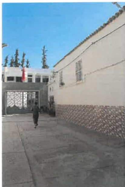
PH 29 et 30 : présence de revêtement en grés cérame sur façades
