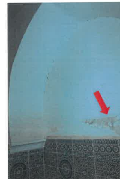
PH 22 : Fissure horizontale sur dalle
