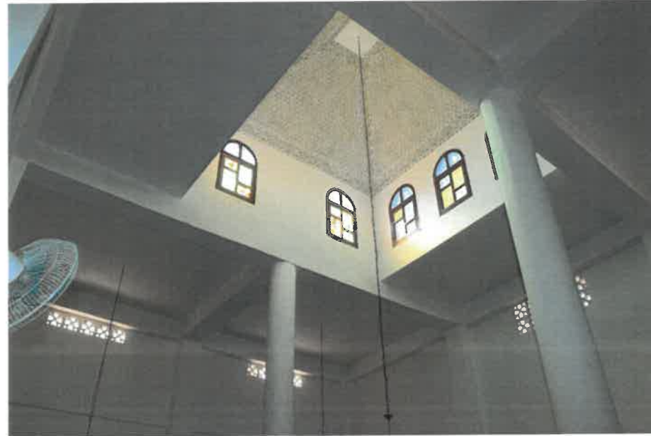
PH 51,52,53 et 54 : Présence d'une coupole en béton armé au centre du Sahn
