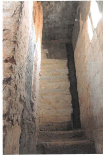
PH 67,68,69,70,71 et 72: Surélévation en béton armé sur l'Azri initial (poteaux, poutre, dalle et escalier en béton armé)
