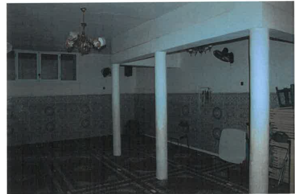
PH 37: présence de revêtement en grés cérame sur mur S,P,F
