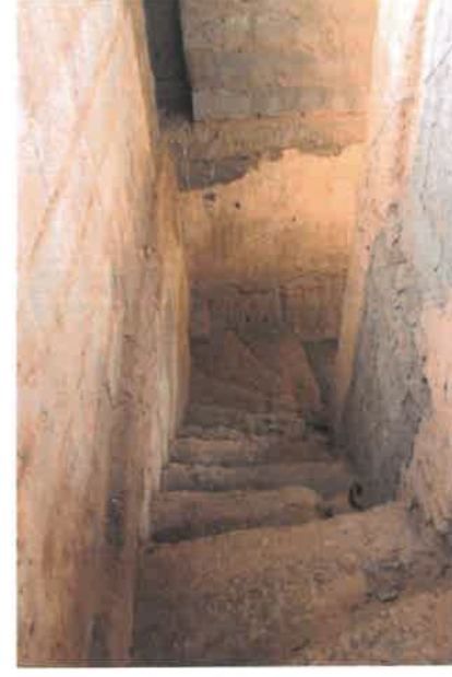
PH 67,68,69,70,71 et 72: Surélévation en béton armé sur l'Azri initial (poteaux, poutre, dalle et escalier en béton armé)
