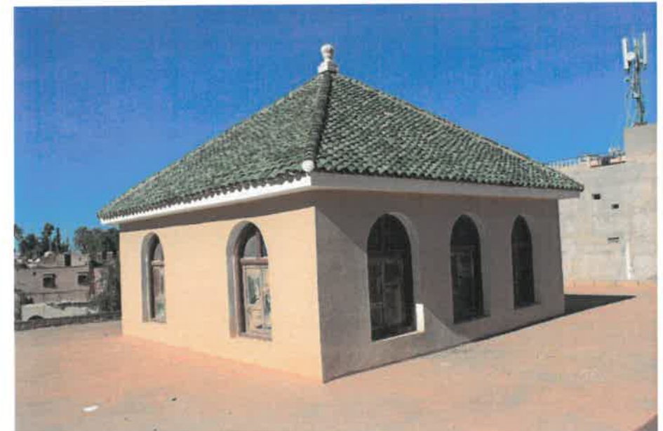
PH 45,46,47,48,49 et 50 : Couverture du Sahn par une structure en béton armé( poteaux, poutres et dalle)
