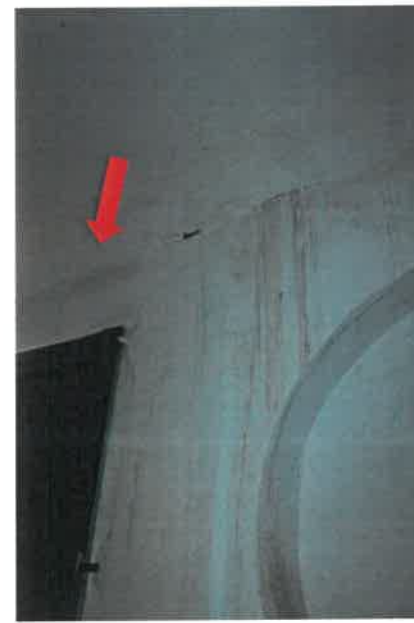
PH 23,24,25,26,27 et 28 : Trace d'humidité sur Mur et dalle
