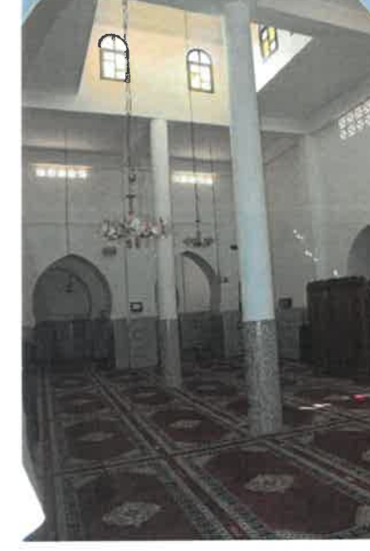
PH 45,46,47,48,49 et 50 : Couverture du Sahn par une structure en béton armé( poteaux, poutres et dalle)
