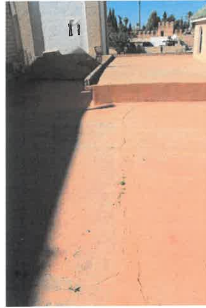
PH 38,39,40 ET 41 : Dégradation de la chape de ciment sur terrasse
