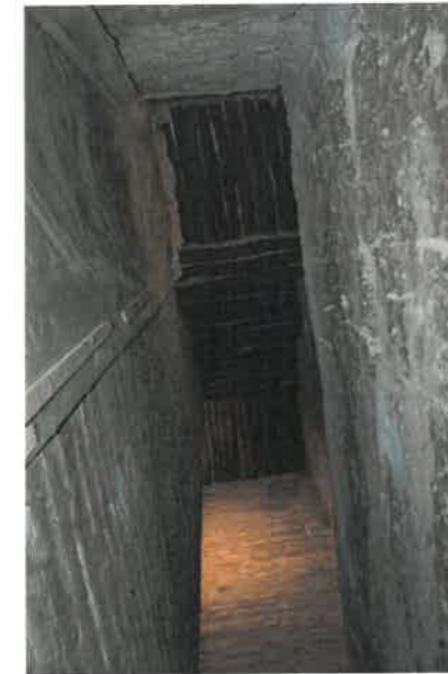
PH 58.59 et 60: Dégradation légère au niveau plancher en rondins du bois
