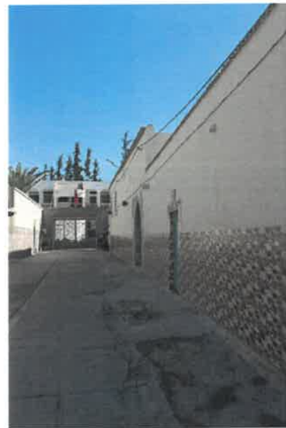
PH 29 et 30 : présence de revêtement en grés cérame sur façades
