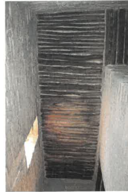
PH 58.59 et 60: Dégradation légère au niveau plancher en rondins du bois
