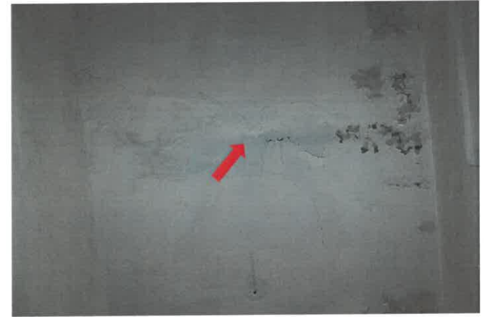
PH 22 : Fissure horizontale sur dalle
