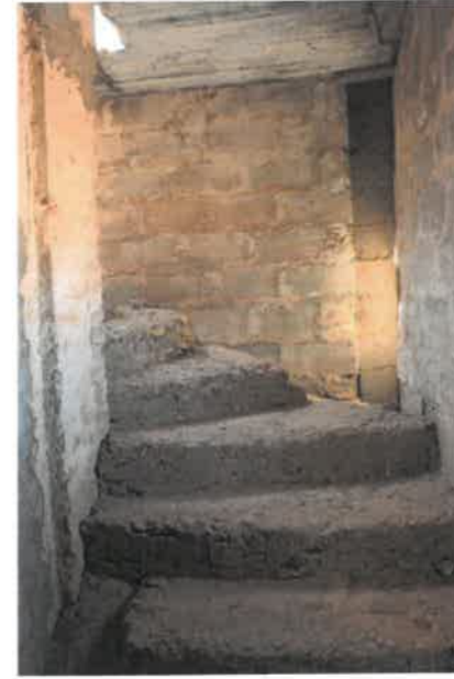
PH 67,68,69,70,71 et 72: Surélévation en béton armé sur l'Azri initial (poteaux, poutre, dalle et escalier en béton armé)
