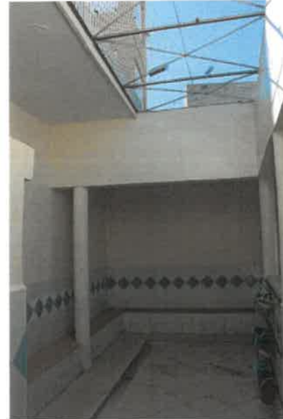
PH 9,10,11,12 et 13 : Présence des poteaux et dalles en béton armé (Bloc sanitaire)
