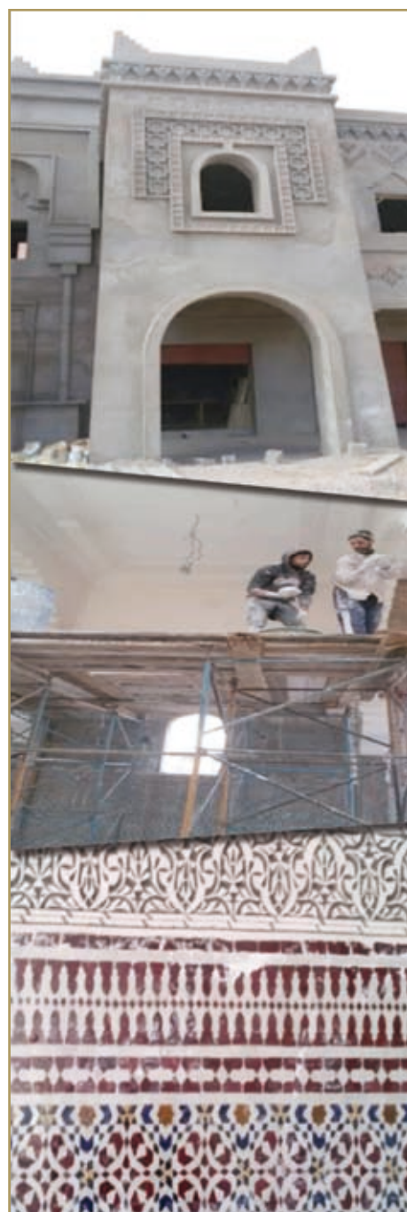
ورش مشروع بناء المركب الديني والثقافي للأوقاف بتنغير
