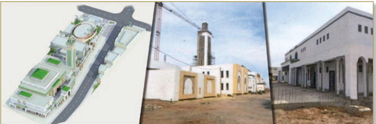
ورش مشروع بناء المركب الديني والثقافي للأوقاف بسيدي بنور
