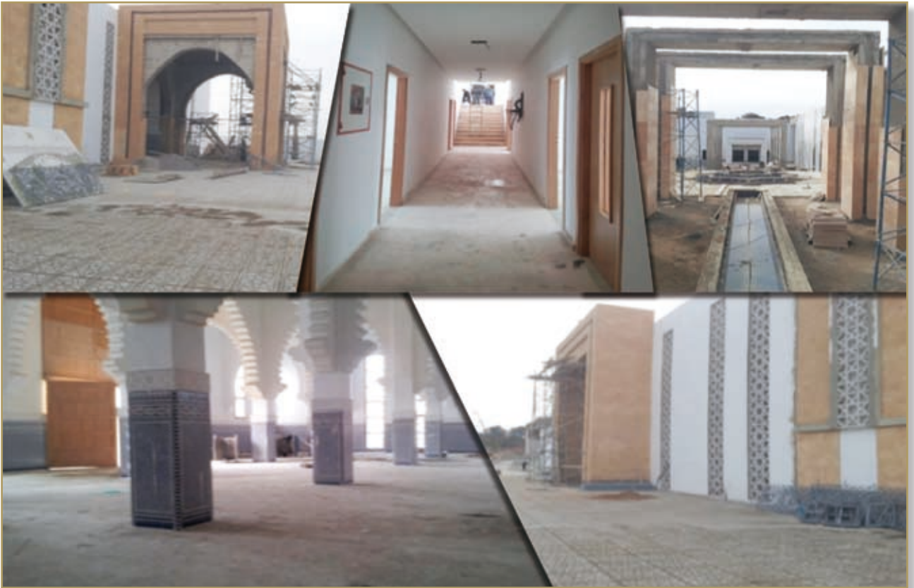
ورش مشروع بناء المركب الديني والثقافي للأوقاف ببني سليمان
