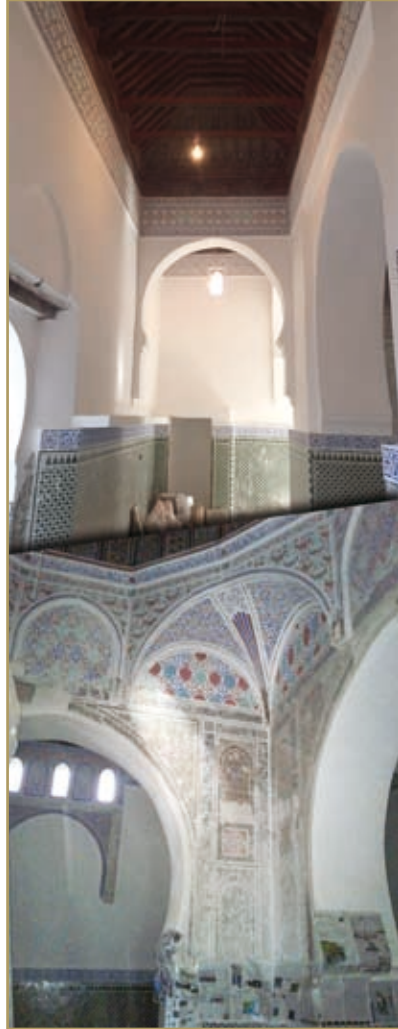
ورش ترميم ضريح سيدي قاسم بوعسرية مهدينة سيدي قاسم
