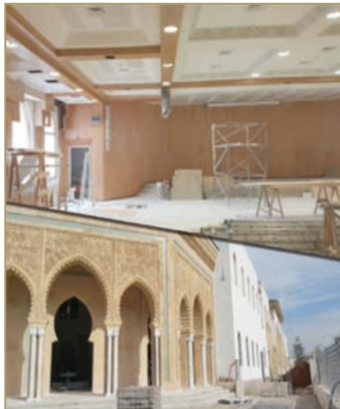
ورش مشروع بناء المركب الثقافي والإداري للأوقاف بالدار البيضاء
