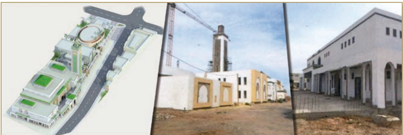
ورش مشروع بناء المركب الديني والثقافي للأوقاف بسبيدي بنور
