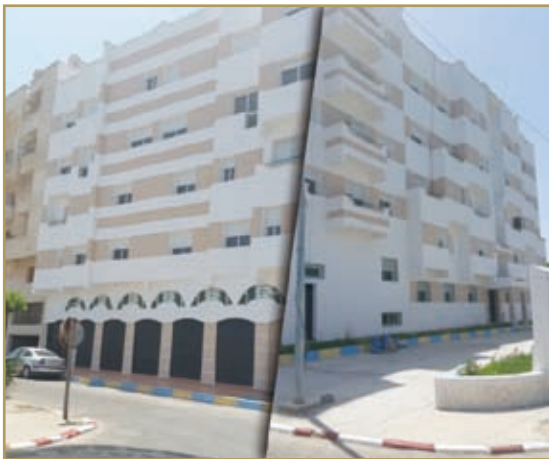
بناء عمارة سكنية بزقة عدن بمدينة آسفي
