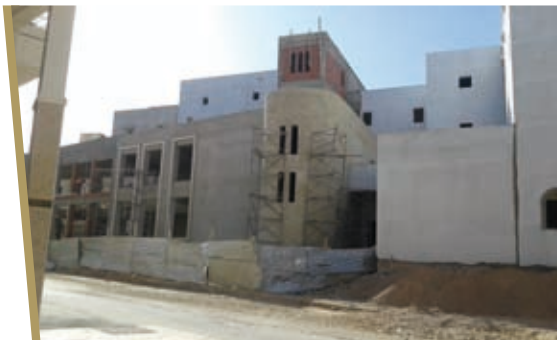
أشغال بناء مدرسة للتعليم العتيق بصفرو
