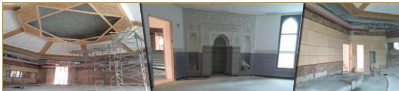
ورش مشروع بناء المركب الثقافي والإداري للأوقاف بطنجة
