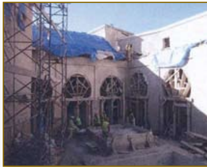
ورش مشروع ترميم مدرسة الصفارين بفاس المدينة
