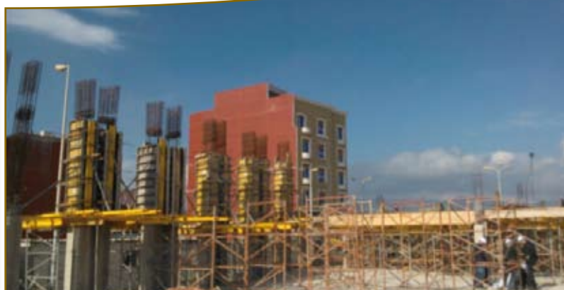
ورش مشروع بناء المركب الديني والثقافي للأوقاف بمدينة الناضور
