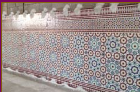
ورش مشروع بناء المركب الديني والثقافي للأوقاف بمدينة تنغير
