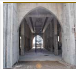
ورش مشروع بناء المركب الديني والثقافي للأوقاف بمدينة بنسليمان
