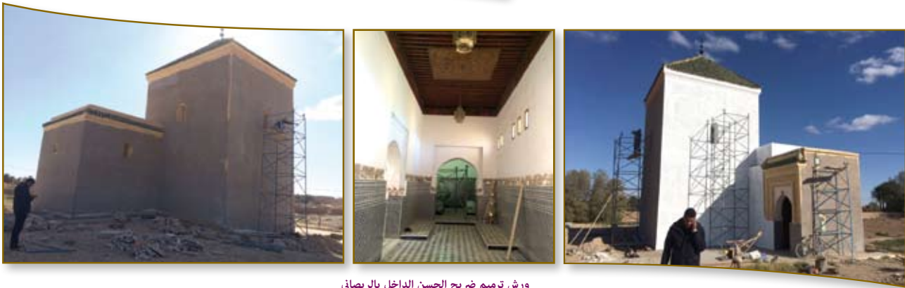
ورش ترميم ضريح الحسن الداخل بالريصاني
