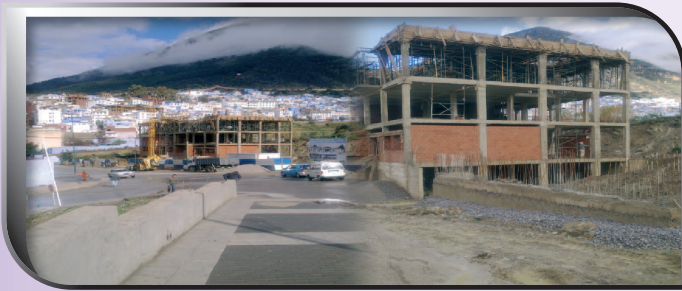
ورش بناء المركب الديني والثقافي والإداري للأوقاف بمدينة شفشاون
