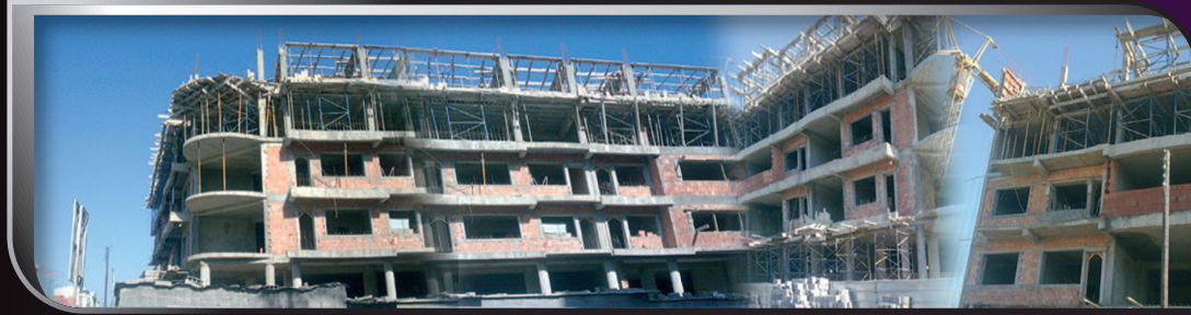
ورش بناء العمارة حرف «أ» السكنية والتجارية من فئة خمس طوابق بحي القبيبات بمدينة الرباط
