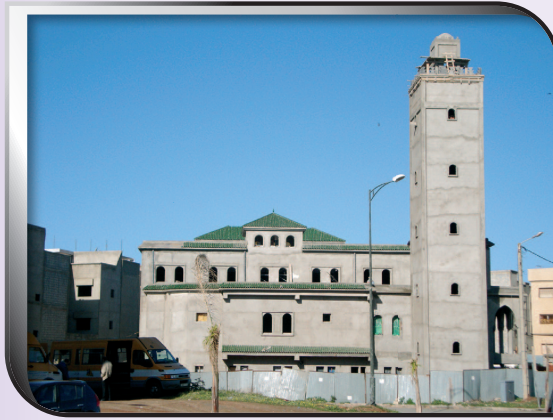
ورش بناء مسجد بحي الكتبية بمدينة سلا
