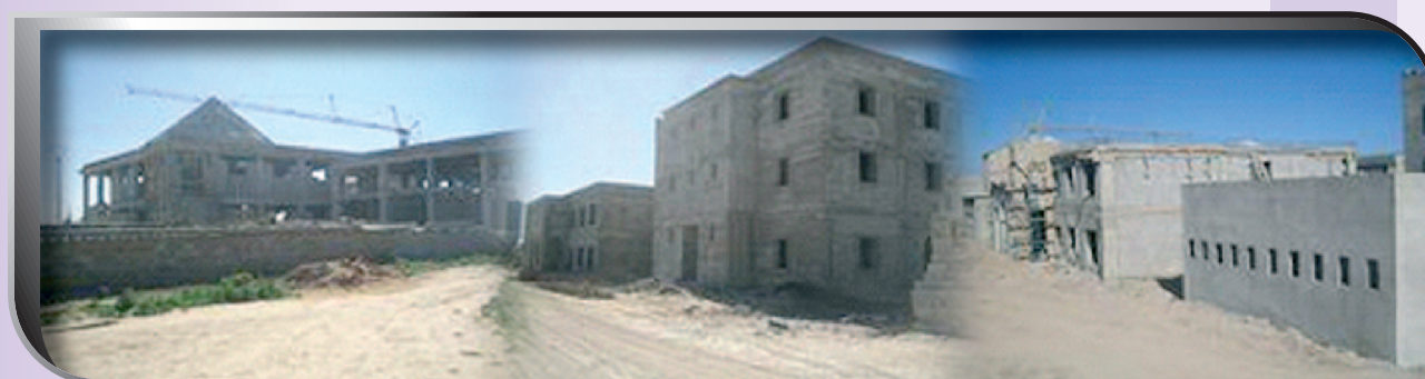
ورش بناء مقر المركب الديني والإداري والثقافي للأوقاف بمدينة تارودانت
