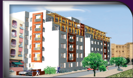
مشروع بناء العمارة السكنية والتجارية حرف «ب» بحي القبيبات بمدينة الرباط
