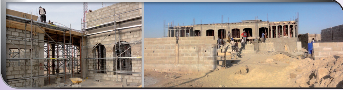
ورش أشغال بناء مسجد بانجمينة بتشاد
