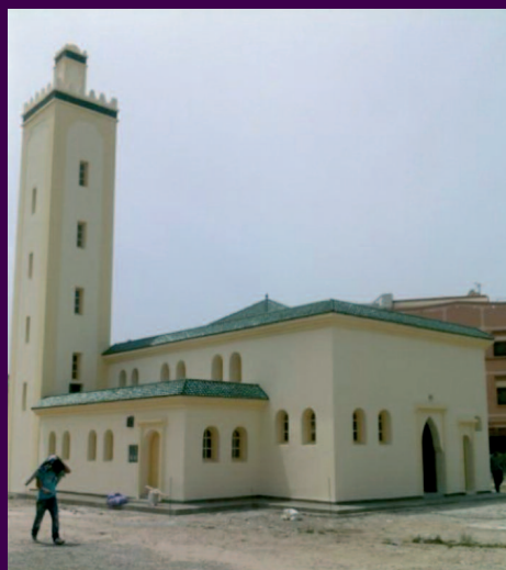
مسجد بتجزئة سعيدة 1 بمدينة آسفي
