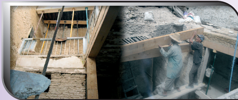
ورش تدعيم وترميم إحدى الدور الحبسية الآيلة للسقوط بالمدينة العتيقة بمدينة فاس
