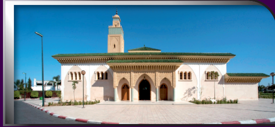
مسجد للا خديجة بحي الرياض بمدينة الرباط
