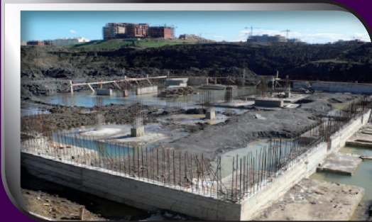
بناء الأسس لبناء المركب الثقافي والإداري للأوقاف بمدينة طنجة
