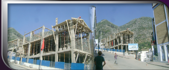
ورش بناء مرائب للسيارات ومركب سكني وتجاري بمدينة شفشاون
