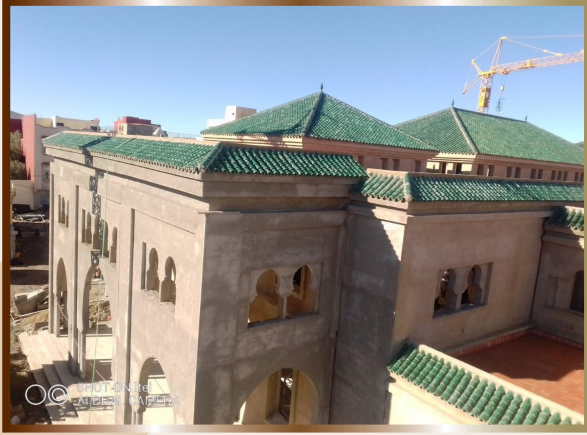
بناء مسجد ومرافقه بمركز مريرت بخنيفرة
