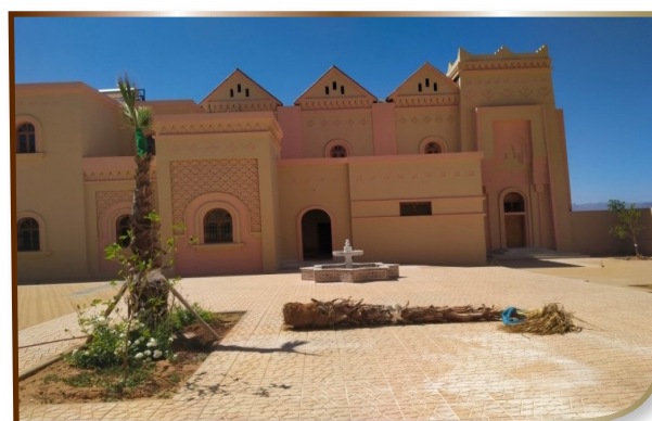
ورش مشروع أشغال إتمام المركب الديني والثقافي تنغير
