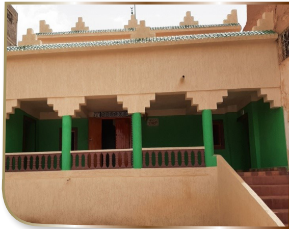
ترميم ضريح سيدي داود بحي سيدي داود بورزازات
