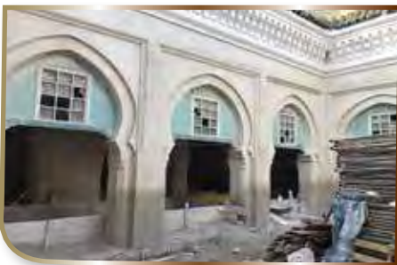
ترميم مسجد الجامع الجديد بطنجة
