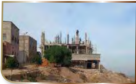
ورش إعادة بناء مسجد لكنيز بني عياط
