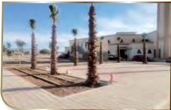
أشغال تهيئة منطقة الألعاب الكائنة بتجزئة الأوقاف «رقعة شك الحيط» بوجدة
