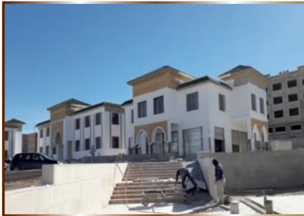
ورش مشروع بناء المركب الديني والثقافي للأوقاف بتاوريرت
