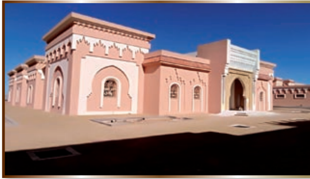
ورش مشروع بناء المركب الديني والثقافي للأوقاف بابن جرير
