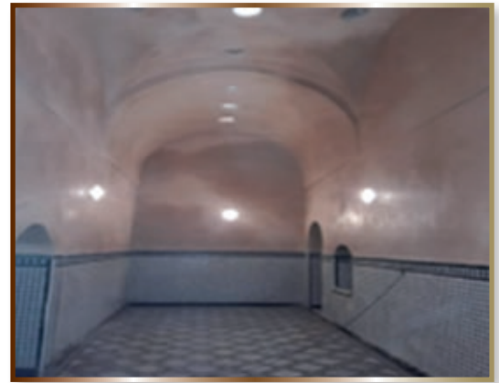
ورش ترميم وتهيئة حمام الصفارين بفاس
