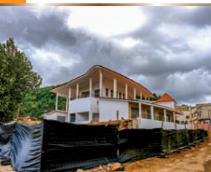
ورش مشروع بناء الشطر الثاني من المركب التجاري الوقفي بأزرو
