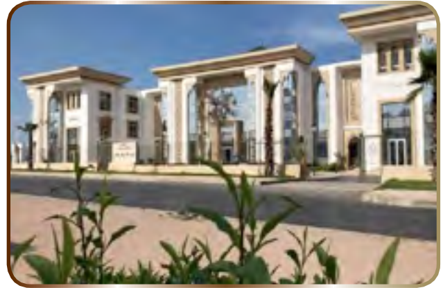
ورش مشروع بناء المركب الديني والثقافي بسلا
