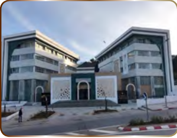
ورش مشروع بناء المركب الديني والثقافي بالحسيمة
