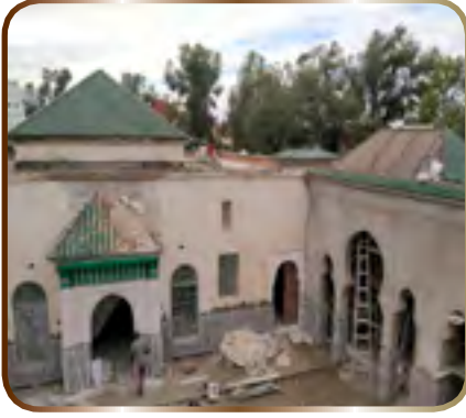
ورش ترميم ضريح مولاي علي بوغالب ومرافقه بالقصر الكبير
