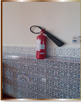
توزيع طفايات الحريق برسم سنة 2019 حسب الجهات
