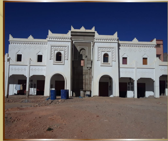
ورش مشروع أشغال إتمام المركب الديني والثقافي بمدينة تنغير
